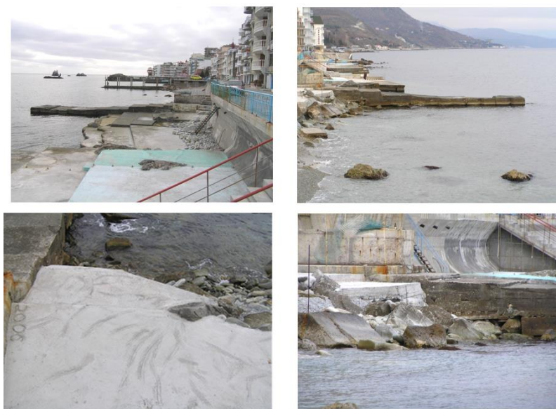
Рис. 1-4. Берегоукрепительные сооружения в пос. Утес, Крым (1998–2006 гг.)
