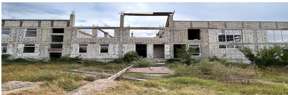
Рис.1. Общий вид фасада недостроенного объекта
