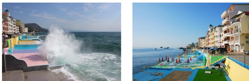
Рис. 7-8. Набережная и берегоукрепительные сооружения в пос. Утес, Крым (настоящее время)
