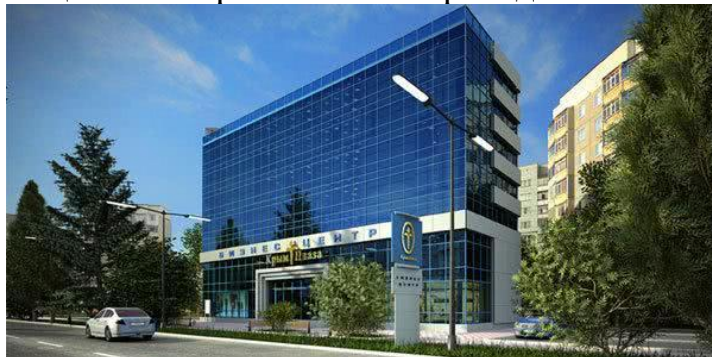
Рис. 1. Общий вид строения бизнес-центра
