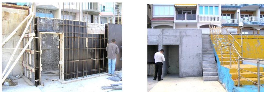
Рис. 5-6. Реконструкция берегозащитных сооружений
